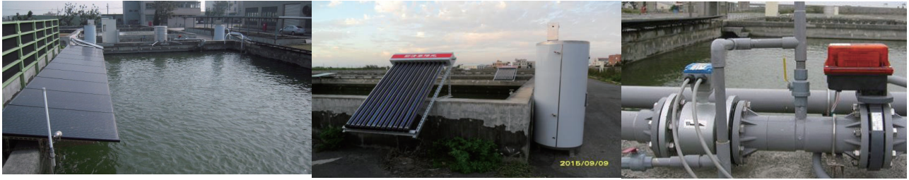
註：(A)全系統建置後之實體照，(B)池水加溫裝置之實體照片，(C)用水監控裝置照片。
