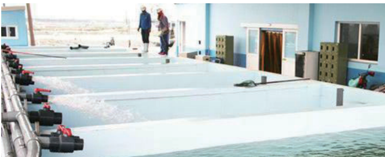
盛洋冷凍暫存蓄養池外觀
