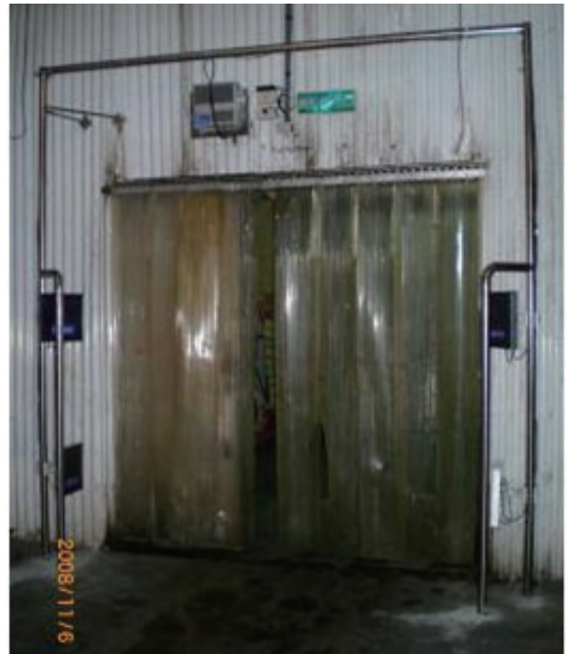
圖十五 傑農合作農場冷藏庫入口RFID讀取閘門
