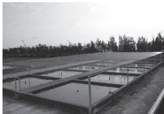
圖五 100 m 2 水泥養殖池加裝防鳥網隔離防疫設施
